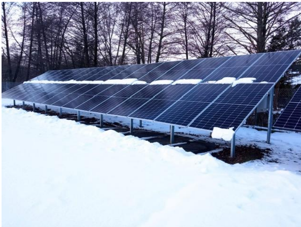
Rozbudowa instalacji fotowoltaicznej w Sędziszowie
