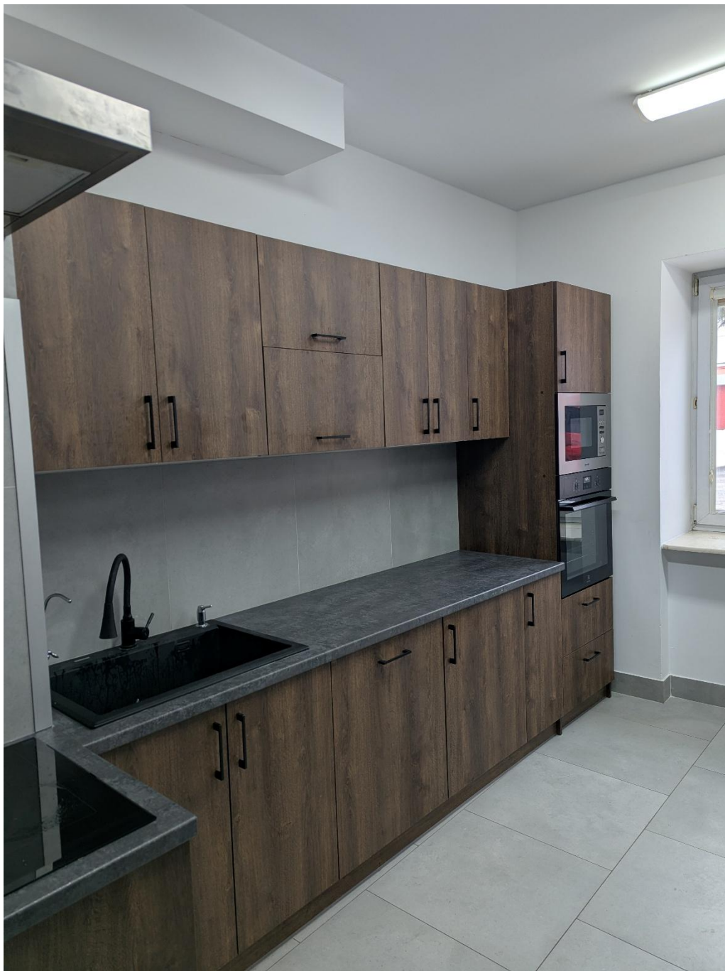
Wykonano remont pomieszczenia socjalnego JRG na parterze budynku Komendy. Koszt całkowity remontu wraz ze sprzętem AGD wyniósł 26.858,00 zł
